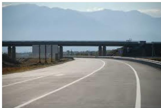
Объездная дорога: Бишкек-Кара-Балта
